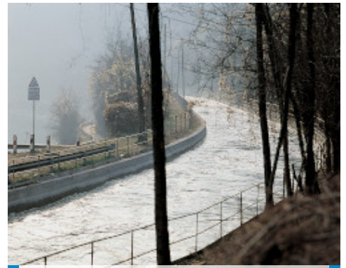
Canal hydroélectrique Bertini - Robbiate (Como) - Italie. Surfaces traitées avec Planiseal 88
